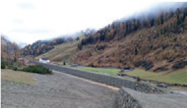
Die Anprallmauern der Dämme wurden als bewehrte Erde-Konstruktion bzw. Grobsteinschichtung ausgeführt
